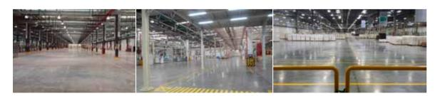
使用后增强混凝土地面的强度、硬度及耐磨性能,使相应指标达到一般混凝土地面的数倍以上,从而形成一个高密度、易清洁、抗渗透的混凝土地面,可免除需周期性重涂的时间及费用。施工简单快捷,有颜色供选择。
